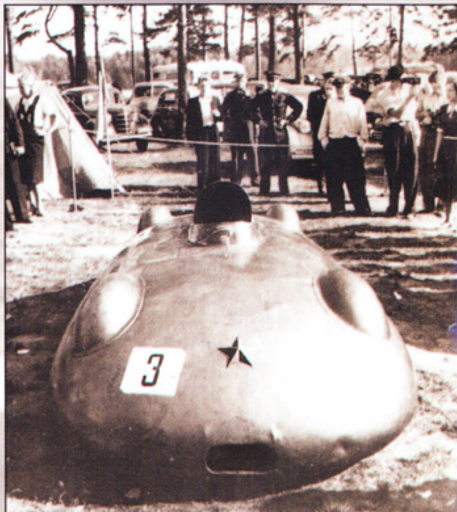
«Звезда-М-НАМИ» имела большую лобовую площадь (1,03 кв. м) и хороший коэффициент обтекаемости – 0,13
